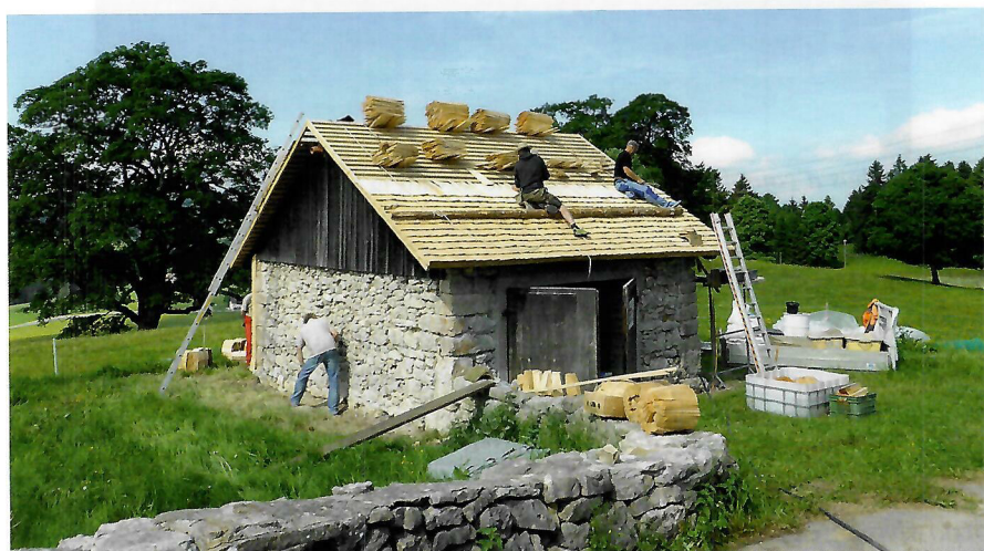
Poje de tavaillons chu ènne leudge dains l'Vâ-d'Ru. Pose de tavaillons sur une loge dans le Val-de-Ruz. Photo Eric Matthey.
