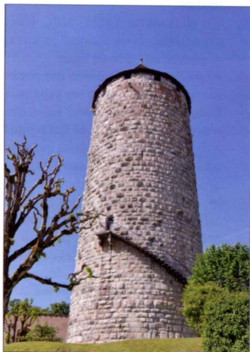
Tour Réfous (vers 1271), château de Porrentruy. Porte à 9 m du sol. Lai toué di tchéte. Dâ lai neüt des temps, èlle voidge lai vèlle. La tour du château. Elle veille sur la cité de- puis la nuit des temps. Photo Bretz, 2022.
